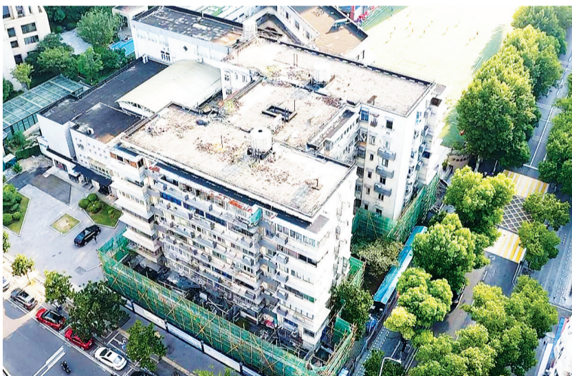
未拆除前的万松园路251号。
