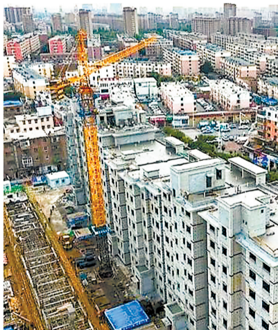
“家和新居”施工进入室内外装修等并行阶段。
